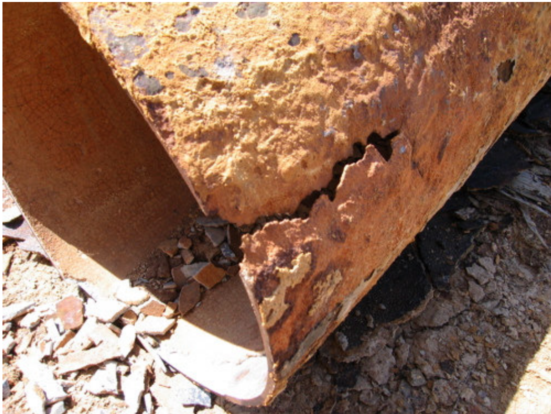
300 DI Raw Water Boyne Smelter Bottom Corrosion
